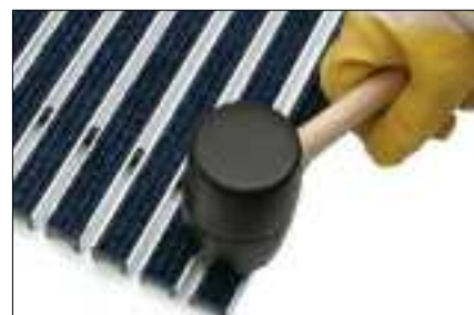
3. Neue Ripsstreifen mit Selbstklebeband in das Aluprofil einkleben und ggf. mit einem Gummihammer den Klebeprozess verstärken.
